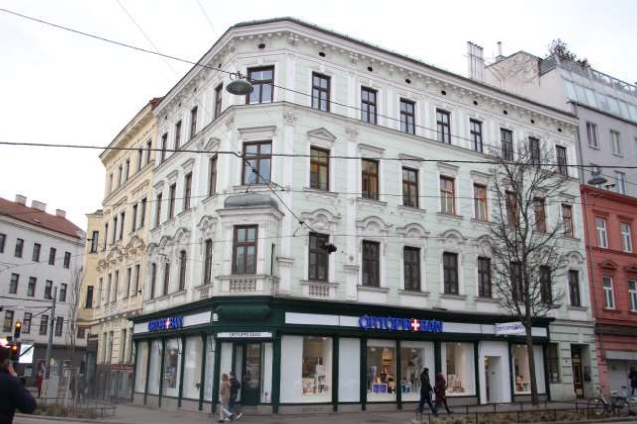
Das Haus in der Breitenseer Straße 1
