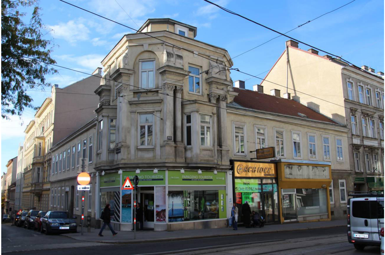
Das Haus in der Hütteldorfer Str. 89
