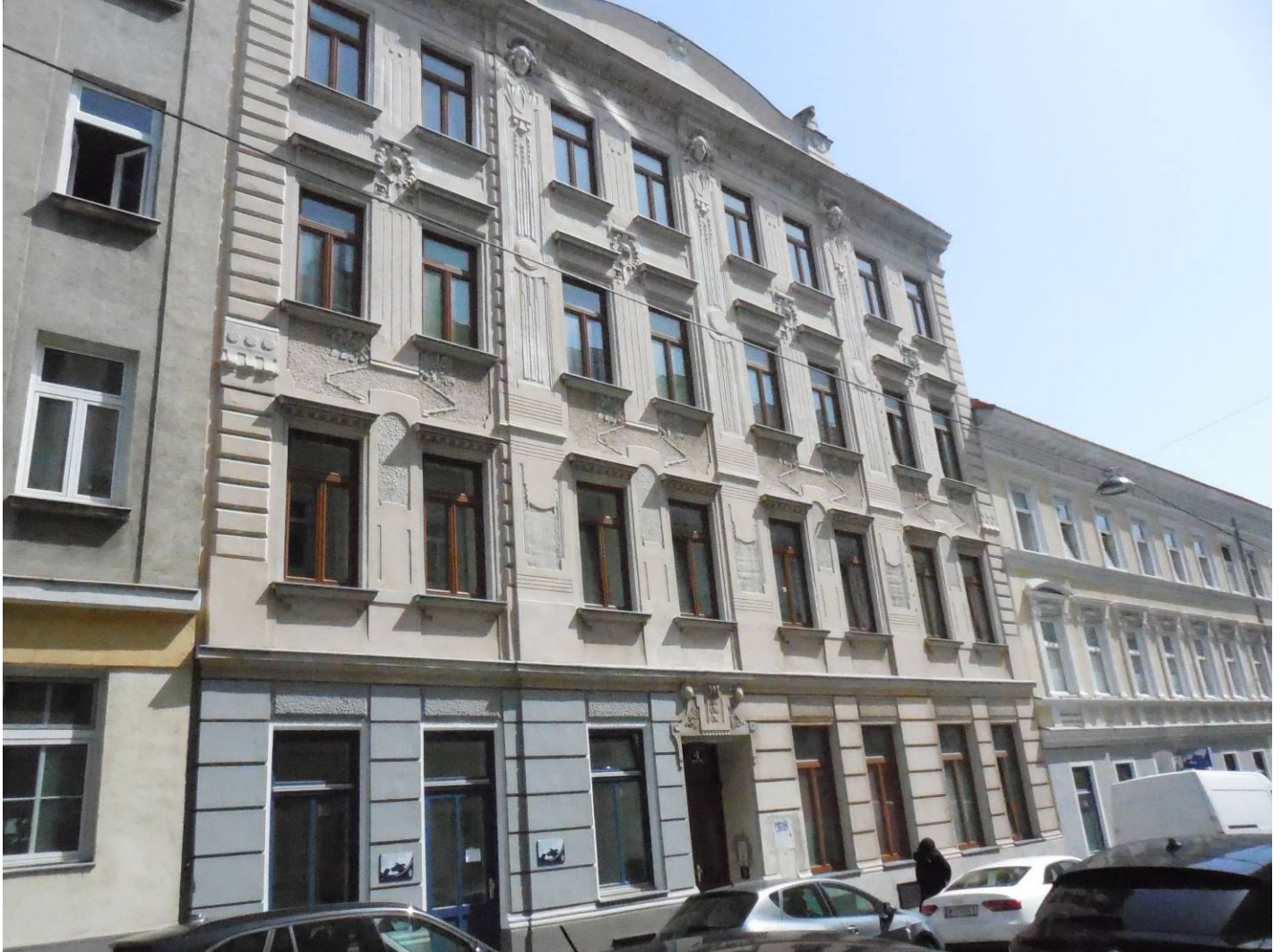
Das Haus in der Draskovichgasse 4
