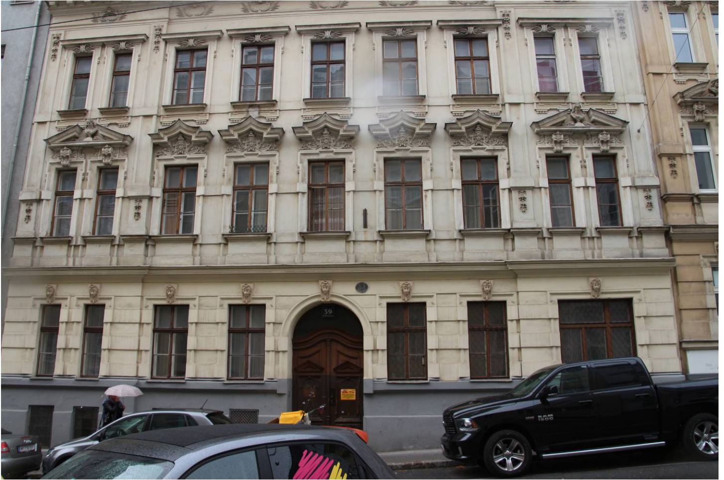
Das Haus in der Nobilegasse 39
